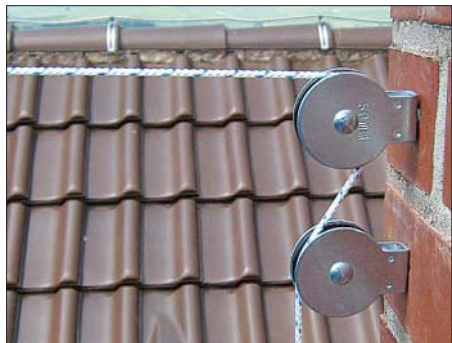
Bild 14: Umlenkrollen am Schornstein; die untere Rolle schafft Abstand für das Spannungsgewicht Fotos und Screenshots: DL1SNG
