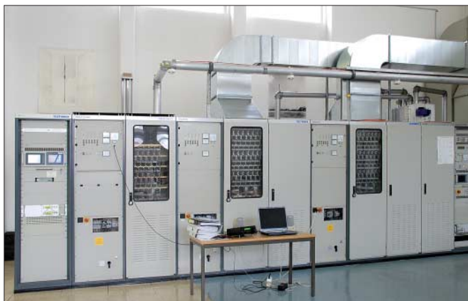
100-kW-Mittelwellensender für 990 kHz
