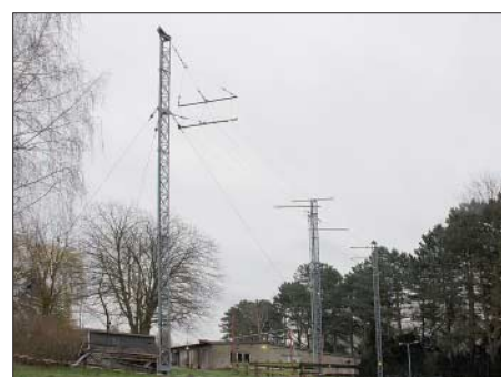
8 m hoher Faltdipol für die Kurzwellenfrequenz 6190 kHz, dahinter das erste Sendergebäude
