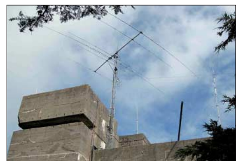
Mehrelement-Richtantenne für die oberen sowie Vertikalantenne für die niederfrequenten Bänder auf ehemaligen militärischen Bollwerken des Zweiten Weltkrieges Foto: OE5HDN
