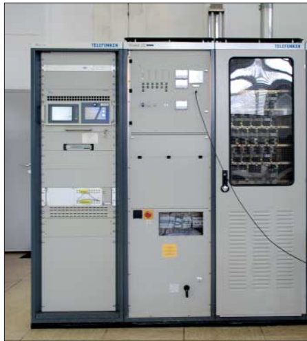
DRM-Sender (14 kW) für 855 kHz
