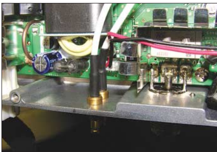
Bild 1: Die beiden neuen Buchsen nach beendetem Umbau
